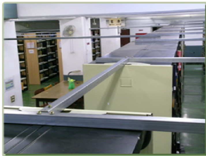
書架頂端以鋼管串連，加強防震
